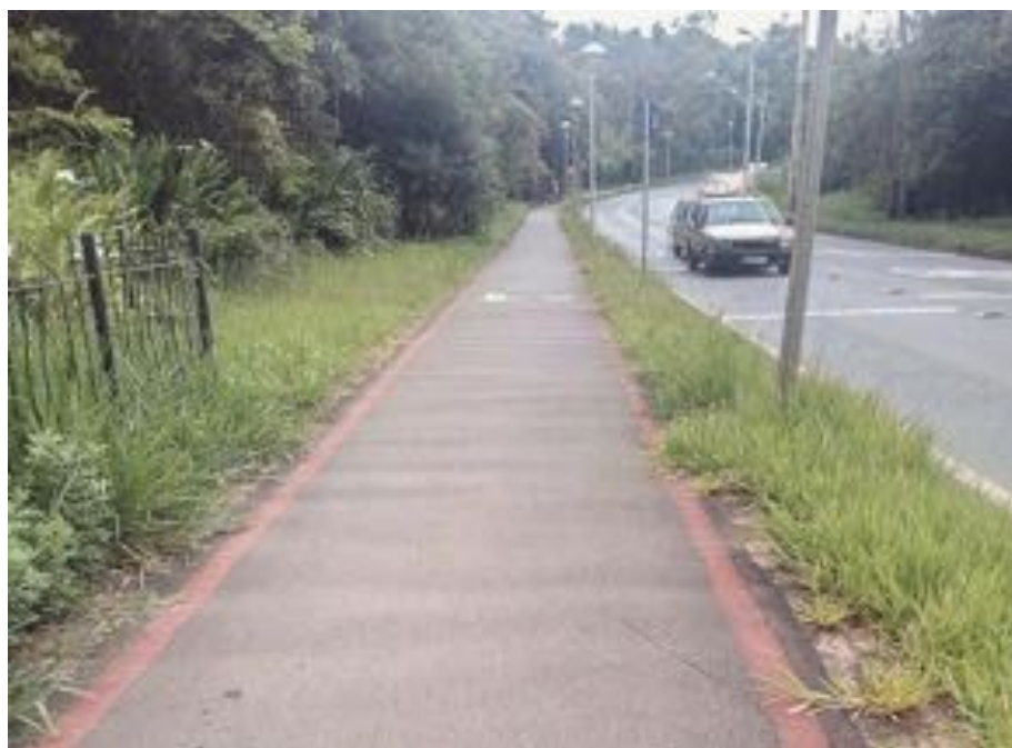
Figura 25: Asfalto ondulado em passeio compartilhado.
