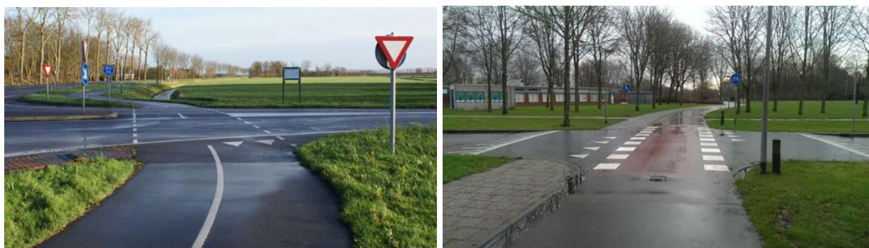
Figura 11: Travessias vistas pela perspectiva de ciclistas, na esquerda com prioridade ao tráfego motorizado e na direita com prioridade para bicicletas. Fonte: Internet, s.n.t.
