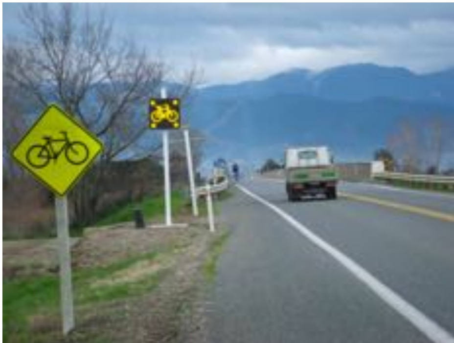
Figura 5: Módulo de segurança acionado por laço indutivo em passagem estreita.
