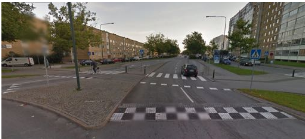
Figura 17: Saída de rotatória com passagens elevadas e prioridade para pedestres e ciclistas (Malmö, Suécia)
