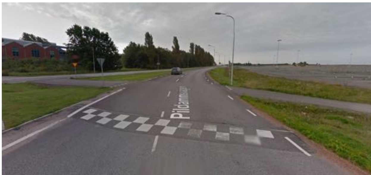
Figura 18: Saída de rotatória com passagens elevadas e prioridade ao tráfego motorizado (Malmö, Suécia).
