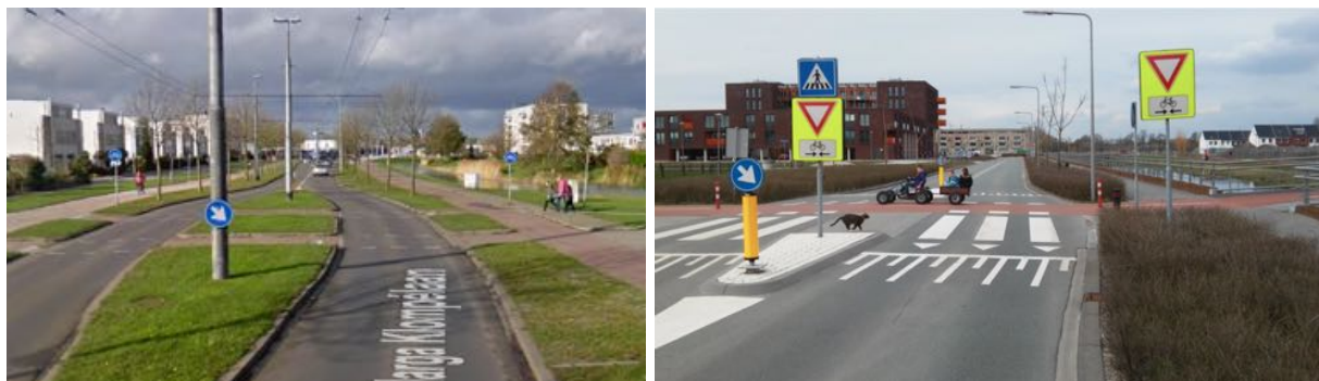
Figura 12: Travessias vistas pela perspectiva de motoristas, na esquerda com prioridade ao tráfego motorizado e na direita com prioridade para bicicletas e pedestres. Fonte: Google Street View / Internet, s.n.t.
