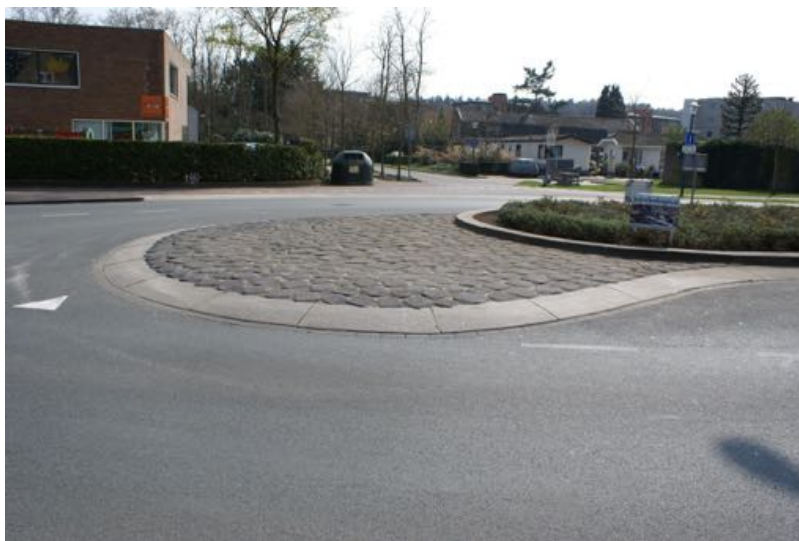
Figura 24: Exemplo de área de transposição para veículos longos. Fonte: Internet, s.n.t. Qualidade do Pavimento das Ciclovias
